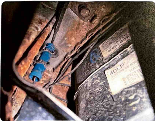
3.1 Rust Mye rust underside ved bakstilling.
