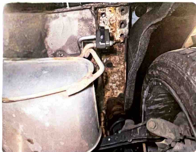
3.1 Rust Mye rust underside ved bakstilling.
