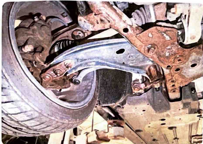
5.1 Øvrige feil Kraftig rustet travers fram.
