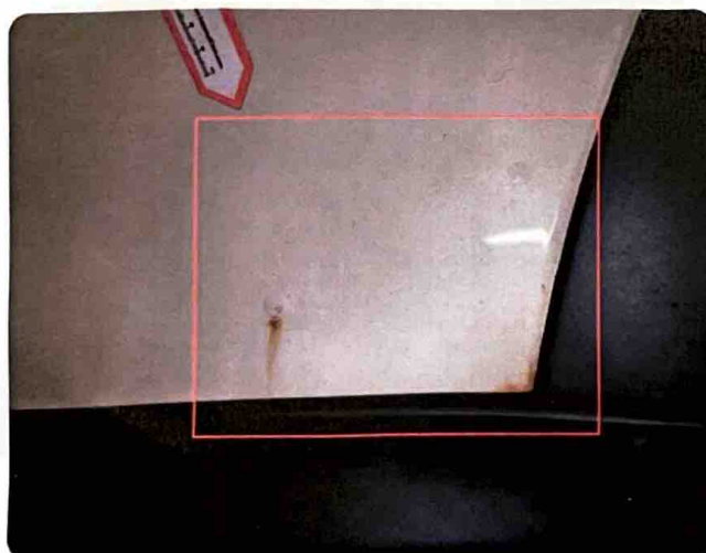
3.6 Rust Rust v-bakskjerm .
