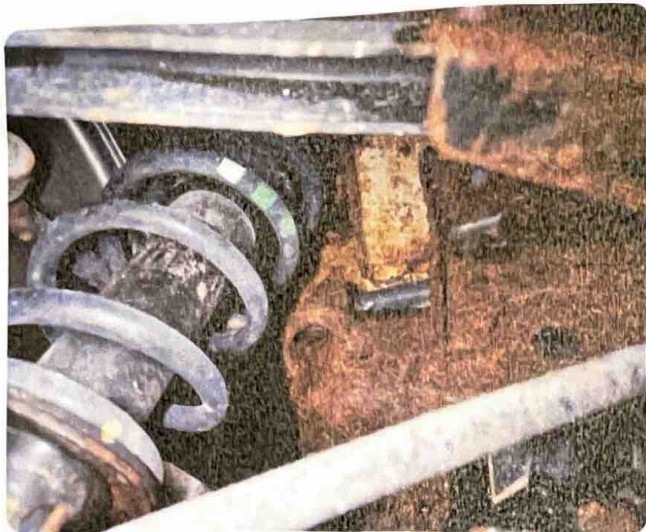
3.1 Rust Mye rust underside ved bakstilling.
