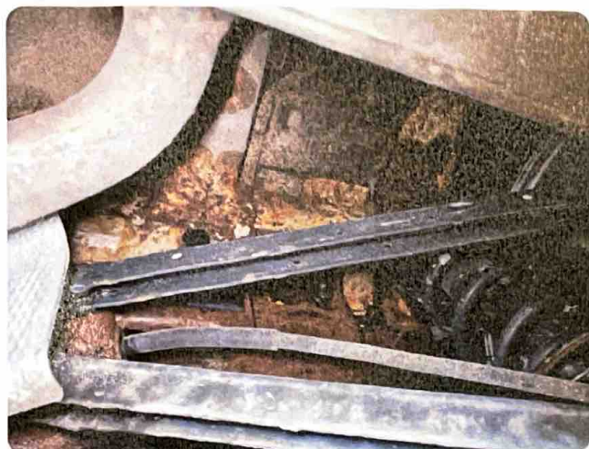
3.1 Rust Mye rust underside ved bakstilling.
